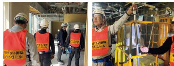
安全パトロールの様子
