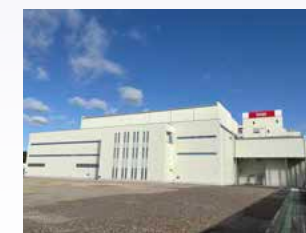
ホーユー桜が丘工場(2024年)
