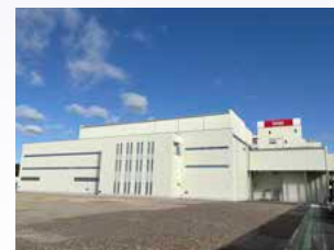
ホーユー桜が丘工場(2024年)
