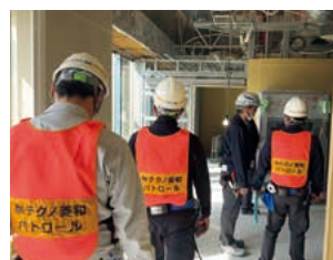
安全パトロールの様子
