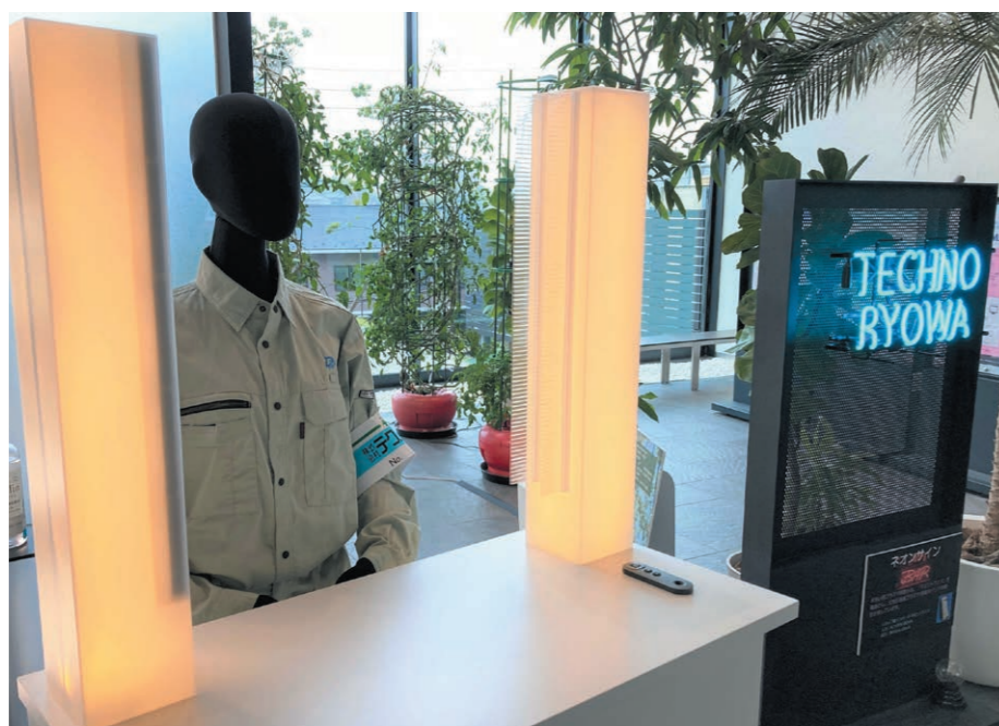
▲受付カウンターに設置したエアセパレート気流システム
