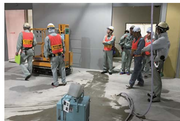
▲施工パトロールの様子
