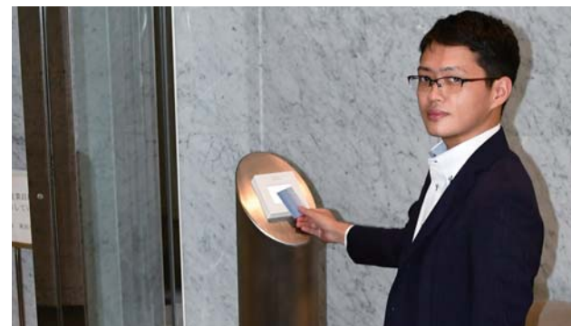
▲カードリーダー式セキュリティシステム
