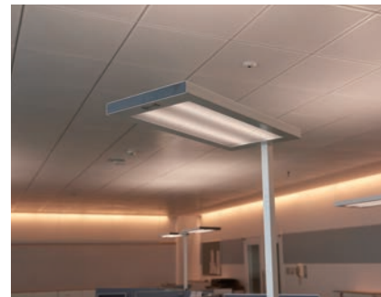
▲照明・空調のタスク&アンビエント化を実現
