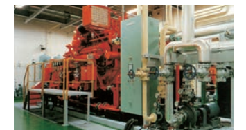
▲コ・ジェネレーションシステムの電源・熱源機械室(1986年)
