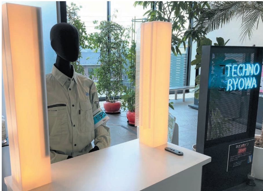
▲受付カウンターに設置したエアアセパレート気流システム
