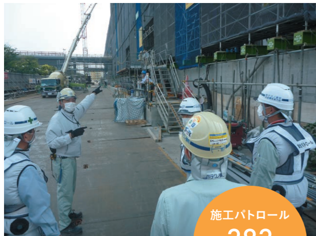
▲安全品質パトロールの様子
