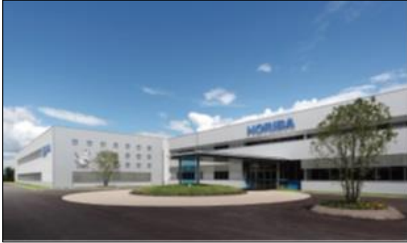
【株堀場エステック 阿蘇工場】
