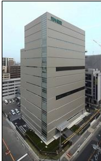
【沢井製薬(株) 開発センター】
