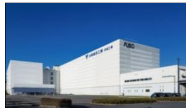
【扶桑薬品工業(株) 茨城工場】
