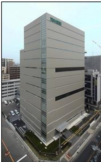
【沢井製薬(株) 開発センター】
