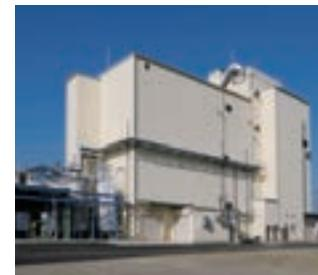
本物件は、業界有数のアミノ酸合成技術を有する新工場として建設されました。医薬品原薬・食品添加物・化成品の製造工場として、厳格な品質管理体制を敷き、国内外に製品を供給する拠点です。空冷モジュールチラー及びスチーム熱源の中央空調方式により、各製造室に適した温度・湿度・室内圧力・清浄度を実現しております。
