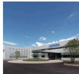
本物件は、阿蘇工場の既存棟の改修と新棟の建設を併せた第4期拡張工事により完成しました。新棟では、主に血液検査装置や検査試薬等の医用製品が生産されています。また、既存棟のクリーンルーム増床工事では、空調の制御を「パッケージ型空調機+FFU方式」で行っています。
