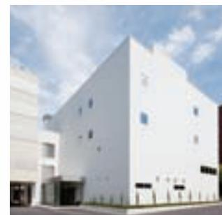
医薬品製造工場である本物件は、環境負荷の低減に配慮し、自然エネルギーを最大限に利用できる空冷ヒートポンプ機器を採用することで、CO<sub>2</sub>の発生量を削減しております。また、生産で使用する集塵機の排気と必要な外気導入量を最適に調整できるシステムを構築することにより、外気処理に必要なエネルギーの削減を図っております。
