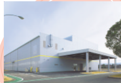
株式会社ニコン水戸製作所新棟建設工事 (茨城県水戸市)
