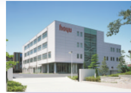
ホーユー株式会社総合研究所新棟 (愛知県長久手町)
