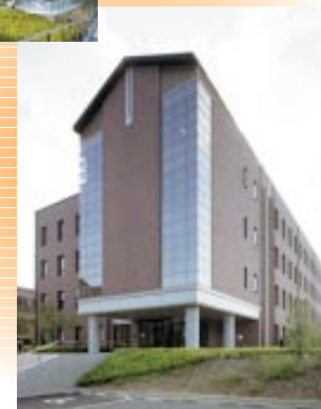
同志社大学工学部新研究室棟(恵喜館) (京都府京田辺市)
