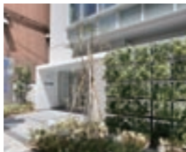
壁面緑化(大阪支店)
