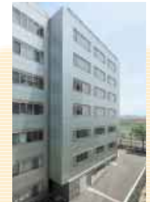
福島大学総合研究棟(理工系) (福島県福島市)
