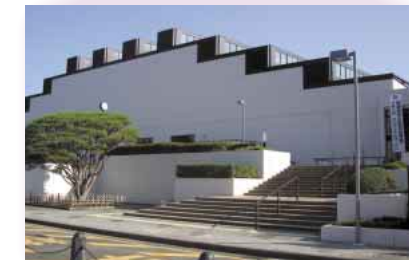
相模原市立総合体育館改修工事 (神奈川県相模原市)
