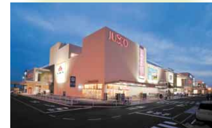
イオン銚子ショッピングセンター熱源設備工事 (千葉県銚子市)
