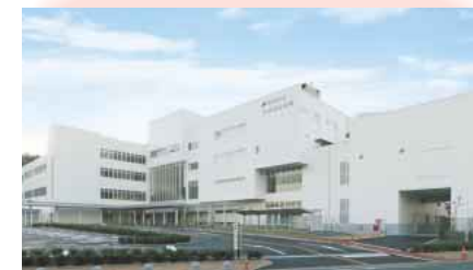
JA愛知厚生連知多厚生病院診療棟 増改築設備工事(愛知県知多郡)
