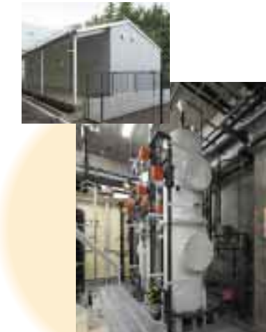
武蔵野美術大学鷹の台キャンパス 特殊排水処理施設及び特殊排水管路整備工事 (東京都小平市)
