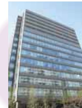
東京海上日動火災保険株式会社 ラ・メール三番町(東京都千代田区)
