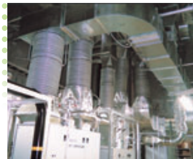
厚木市庁舎 免震改修工事 (神奈川県厚木市)
